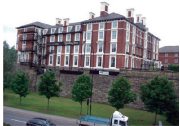
写真③ シェフィールド・ヴィクトリア駅のロイヤル・ヴィクトリア・ホテル(Royal Victoria Hotel)。擁壁の下はもとがキャトル・マーケット。左に運河がある。
