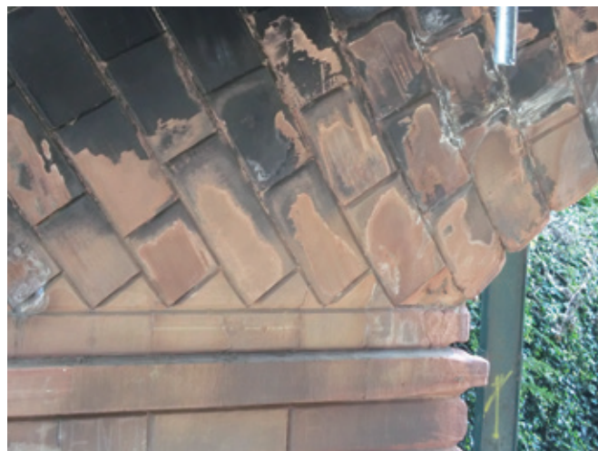
写真② スキュー・ブリッジのアーチのねじり構造
