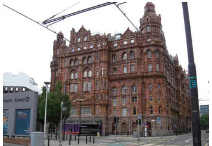
写真⑭ マンチェスタ・セントラル駅とウィンドミル・ストリート (Windmill Street) を挟んで建つ、1903年開業のミッドランド・ホテル。
