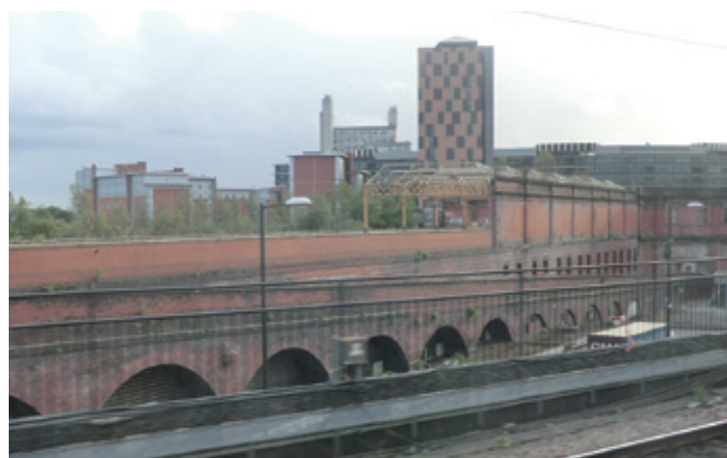
写真⑯ マンチェスタ・メイフィールド駅のプラットホームはアーチのレンガ高架橋の上にある。
