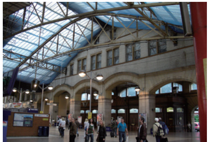
写真11 マンチェスタ・ヴィクトリア駅のエントランス・ホール。アーチの向こうは切符売場。左手から市内循環のトラムの乗り場がある。
