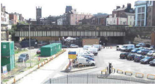
写真⑦ リヴァプール・セントラル・ハイ・レベル駅は切土の中にあつた。左はボールド・ストリート (Bold Street)、右はクロッパー・ストリート (Cropper Street) に囲まれている。
