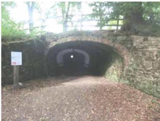
写真③ ロング・トンネルの西坑口。トラムウェイが手前と手前右に分岐するために坑口の幅は拡大している。
