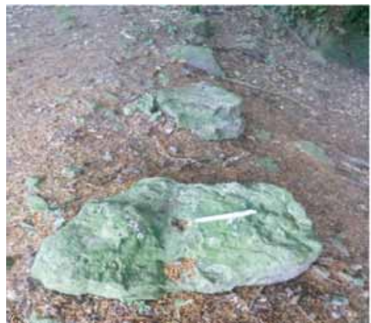
写真② ティックナル・トラムウェイのアーチ橋の上に残る石の枕木。枕木上のボールペンの長さは13cm。
