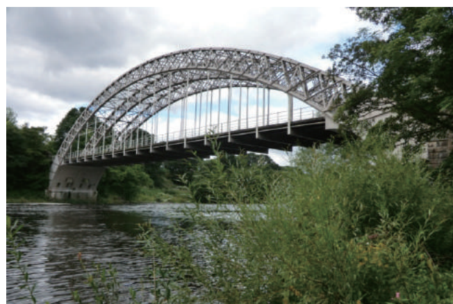
写真⑤ タイン川を横断するハグ・バンク・ブリッジを下流方から望む。この橋梁を列車はもはや走っていない。現在は遊歩道になっている。
