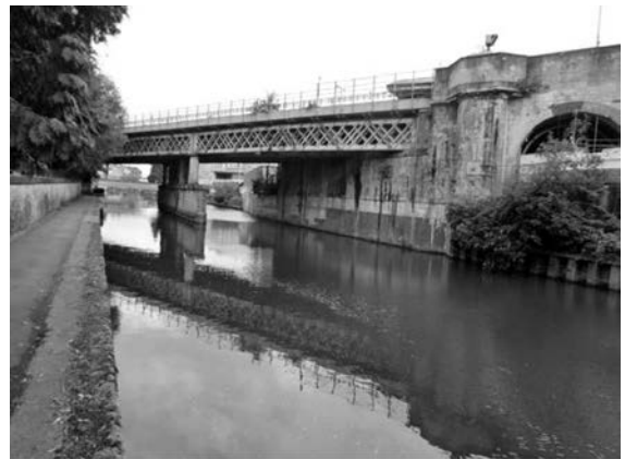
写真-1 バース・エイヴオン橋梁。右はバース駅につながっている。橋脚は1線につき2本の円柱橋脚である。左に見える曳舟道は開業当初と変わらない。
