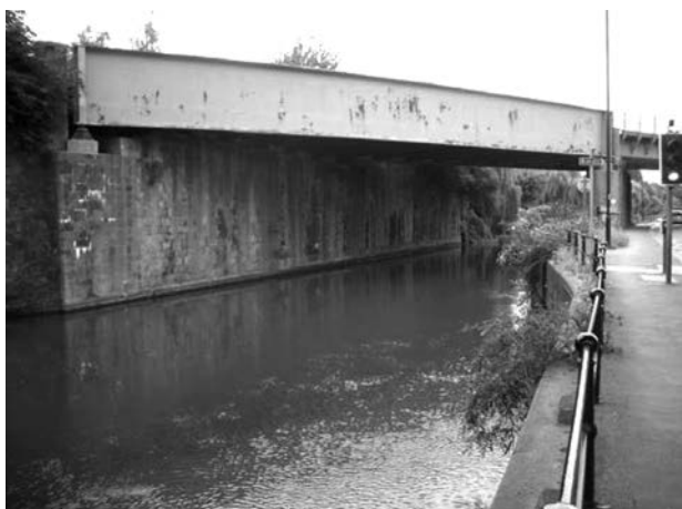
写真-2 フィーダー運河橋梁。左がブリストル方
