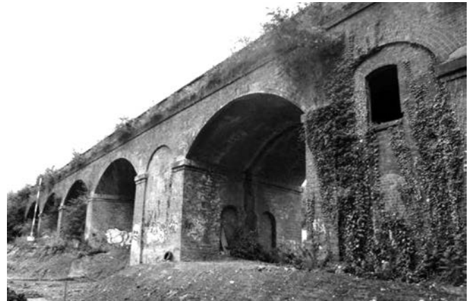
写真-4 ケイペルズ・アンド・カナル高架橋のフルーム川横断箇所。川に近接した染料工場として使用されていた右スパンには窓が見える。
