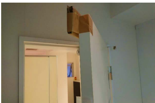
《トイレの換気及び取っ手不触対策》
